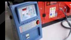
A.S.S.S. réfère à **Automatic Start Stop System** en cas de **coupure de courant** : tous ces groupes électrogènes peuvent être équipés de ce système de **sauvegarde facile** qui est doté d'un **chargeur de batterie incorporé** et d'un auto-test informatisé. Lors d'une coupure de courant, votre groupe électrogène démarre **immédiatement**.
