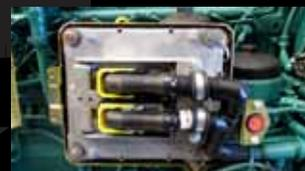
Le **régulateur de vitesse électronique** (Electronic Speed Governor) maintient une **vitesse du moteur et une fréquence de l'alternateur constantes et stables**. Avec l'AVR, il en résulte de meilleures performances pour les appareils sensibles. Tant le **E.S.G.** que l'**AVR** sont nécessaires pour le fonctionnement en **parallèle de plusieurs groupes électrogènes**.
